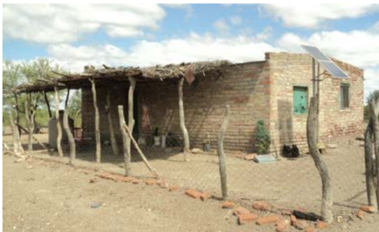
Figura IV.1.4. Arquitectura doméstica. Puesto en La Puntilla
