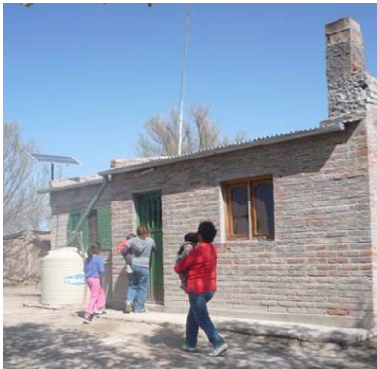
Figura IV.1.5. Vivienda producida por el Estado en Paso Maroma. Fuente: María Eugenia Comerci, 2009.
